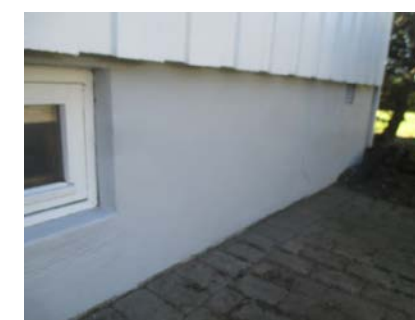
Deler av støpt grunnmur.
