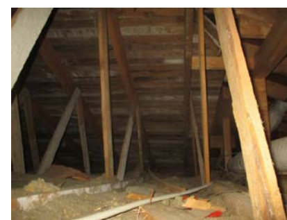
Plassbygget takstoler til en valmet takkonstruksjon.
