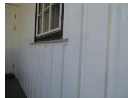
Deler av kledningen med tilhørende belistninger.
