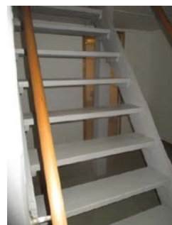
Enkel plassbygget trapp til kjeller.
