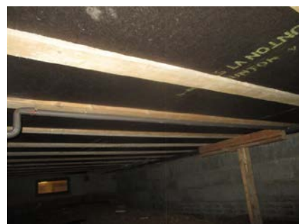
Deler av krypkjeller.
