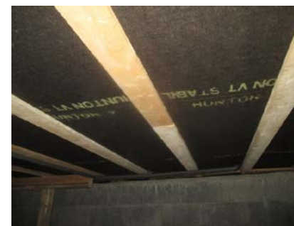
Deler av stubbloftet i krypkjeller.
