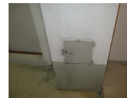
Sotluke i kjeller.
