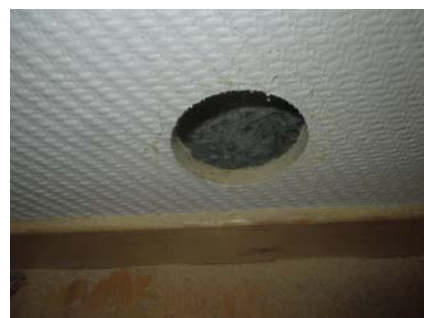
Hulltaking i utfored vegg i kjellerstue.
