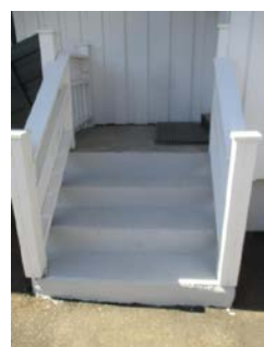
Støpt trapp ved bad/vaskerom.
