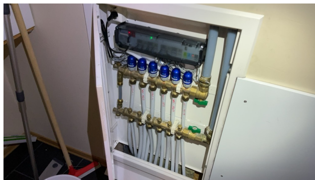
Fordelerskap med styringsenhet, tilknyttet trådløse termostater
