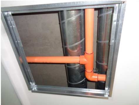
Luke til rør i gang.
