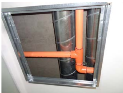
Luke til rør i gang.
