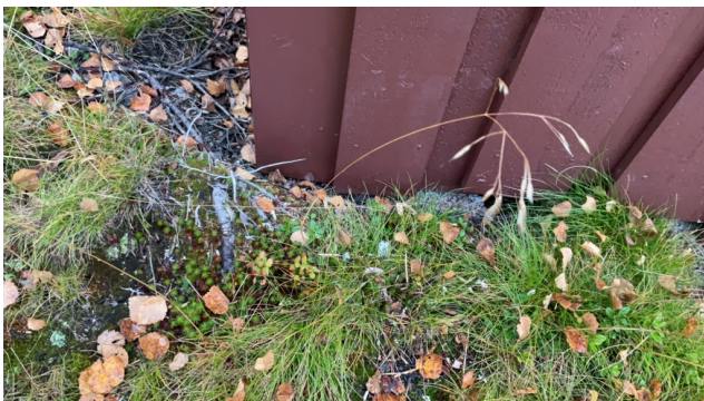
Utvendig bod har enkel fundamentering
