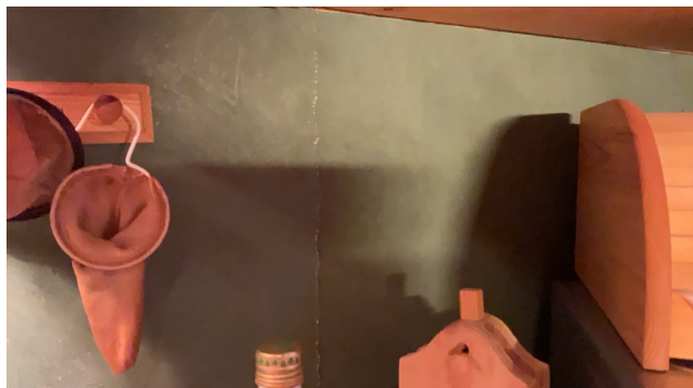
Sprekkdannelse i plateskjøt på tapet
