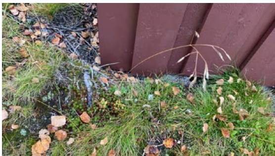
Utvendig bod har enkel fundamentering
