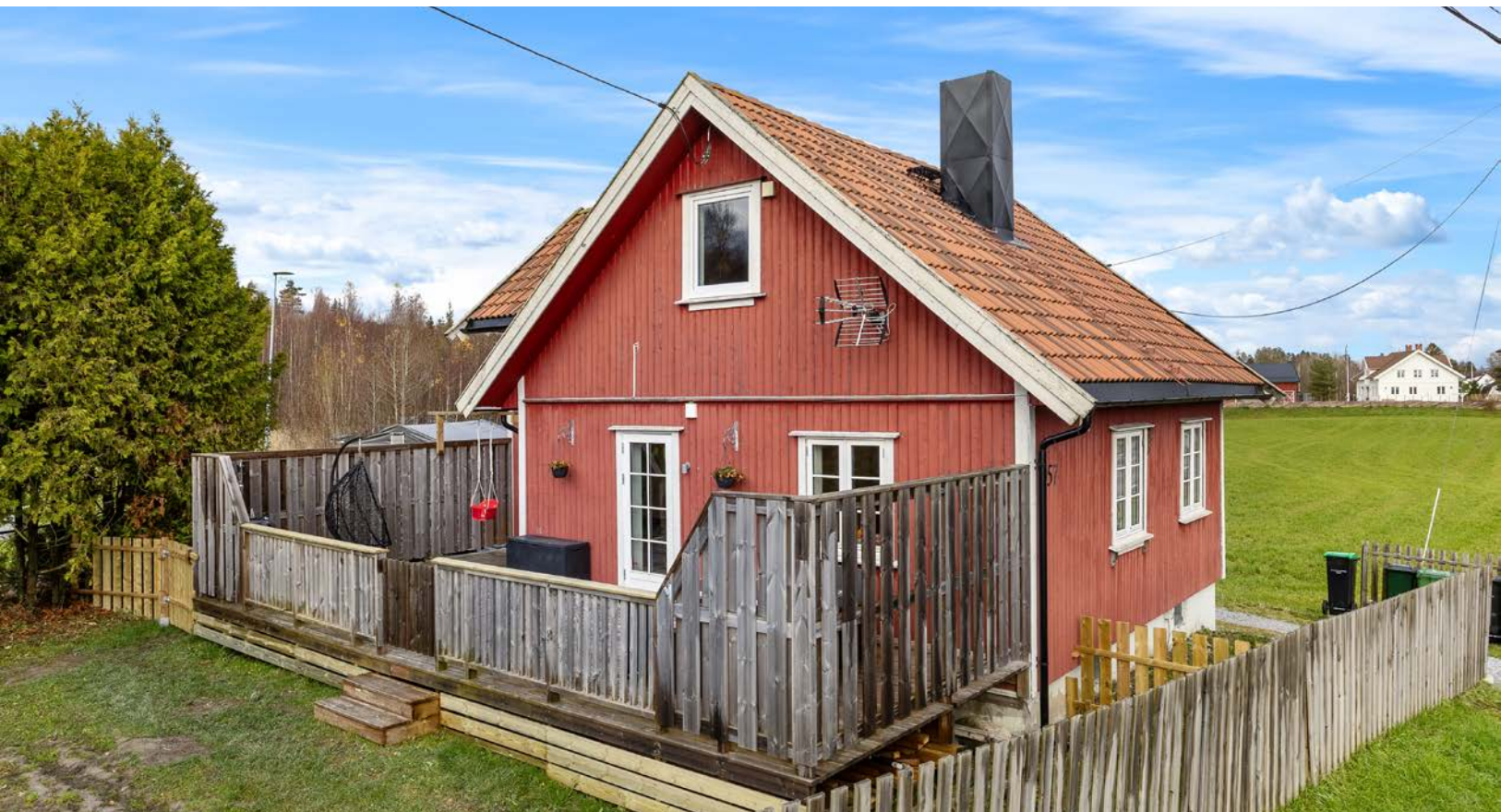
Fra spisestuen er det utgang til en romslig terrasse med landlig utsyn og trapp ned til hagen. Terrassen ble oppført i 2020, utstyrt med belysning og levegger på begge sider.
