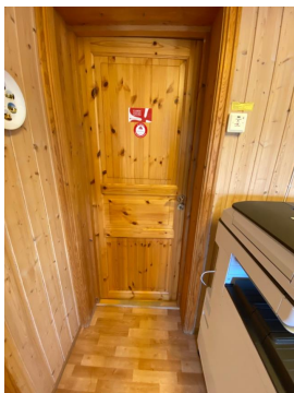
Mangler beslag rundt nøkkelhull inn til kontor.
