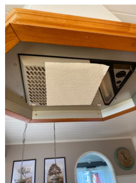
Takhengt ventilator med avtrekk ut i vegg.
