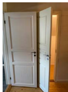
Dør inn til bod i loftsetasjen mangler propper, glippe i listverk.
