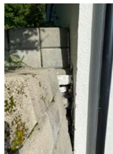
Rekkverk må etableres. Åpning mot mur bør tettes.
