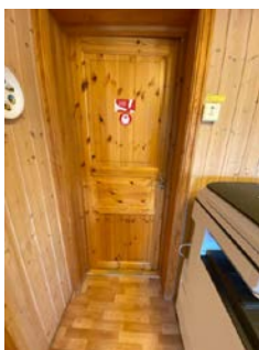
Mangler beslag rundt nøkkelhull inn til kontor.
