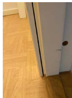
Dør inn til bod i loftsetasjen mangler propper, glippe i listverk.
