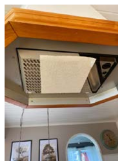
Takhengt ventilator med avtrekk ut i vegg.
