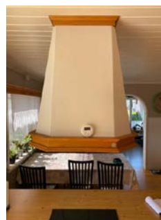
Takhengt ventilator med avtrekk ut i vegg.
