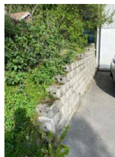
Rekkverk må etableres. Åpning mot mur bør tettes.
