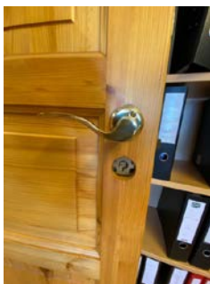
Mangler beslag rundt nøkkelhull inn til kontor.
