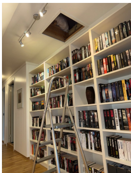
Liten inspeksjonsluke i himling over loftstue/bad.
