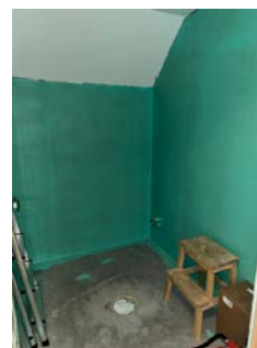
Påbegynt våtrom i tilstøtende rom bak badekar.
