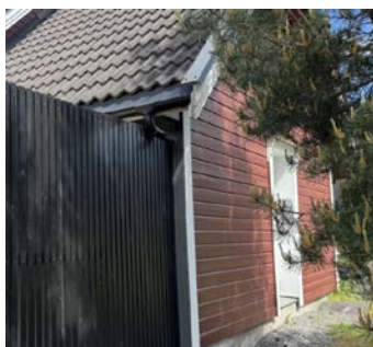
Kun utkast fra takrennekum
