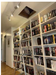
Liten inspeksjonsluke i himling over loftstue/bad.
