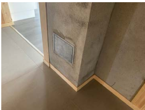
Sotluke i entre.
