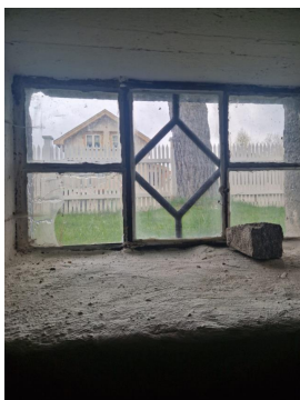
Eldre kjellervinduer fra byggeår
