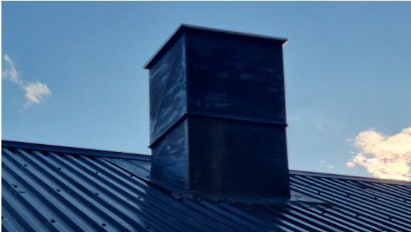
Kontroll av pipebeslag.
