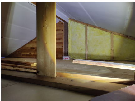
Åpen isolasjon i det ene hemsrommet.
