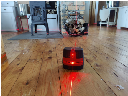
Kontroll av planavvik/skjevheter i gulv.
