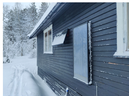
Solcellepanel for solcelleanlegget og solvarmer.
