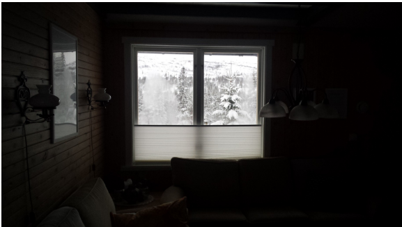
Fukt/kondens i flere av vinduene.
