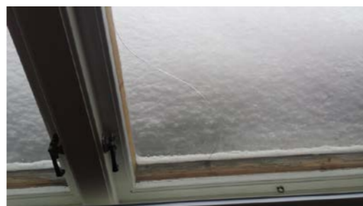
Skadet glass i det ene stuevinduet.
