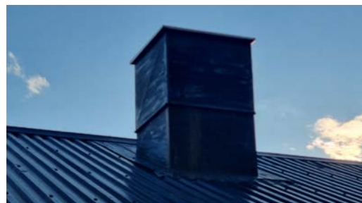
Kontroll av pipebeslag.
