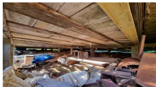
Inspeksjon under hytta.
