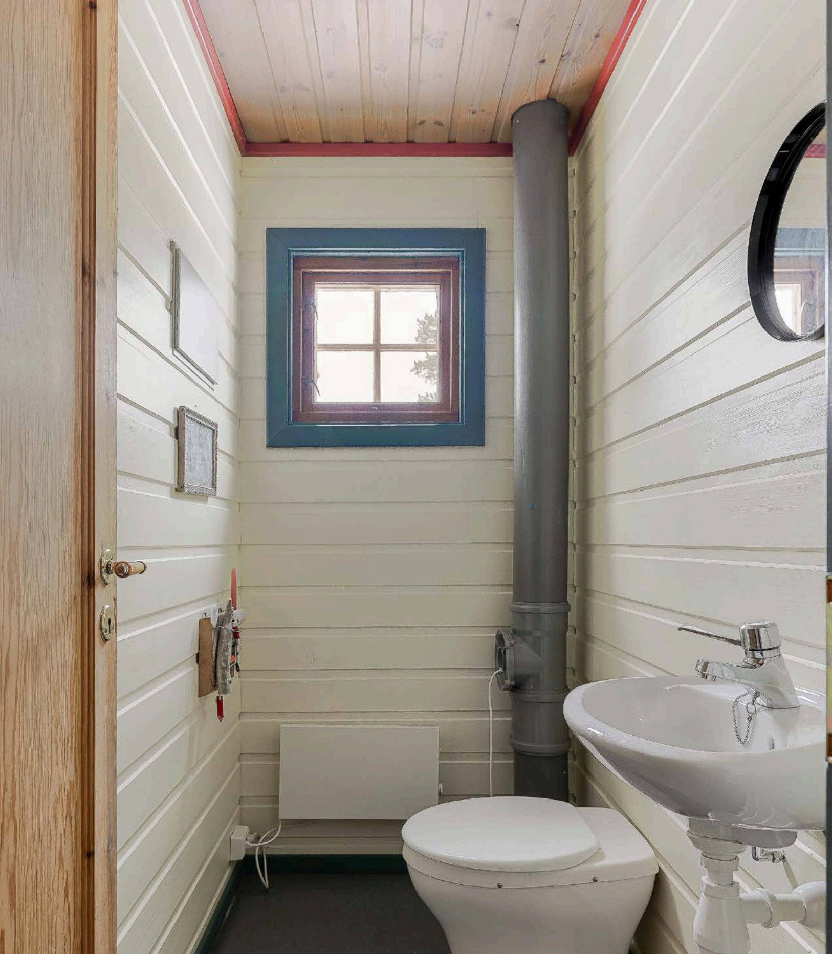
I enden av gangen ligger toalettrommet, som er innredet med bio-do med roterende kammerløsning og vegghengt servant. Rommet varmes opp med panelovn.
