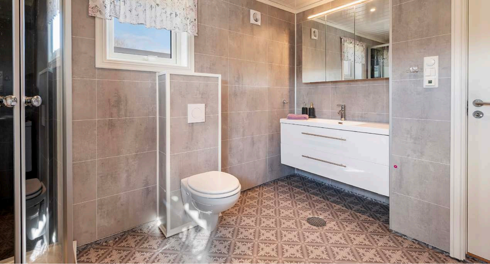
Lys innredning og vegghengt toalett.
