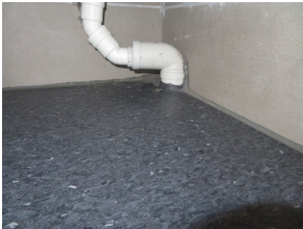
Belegg ved rør-gjennomføring.
