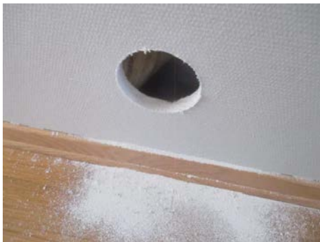
Hulltaking i fra gangen.
