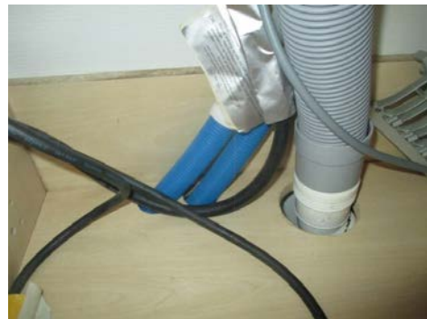
Rør i rør system.
