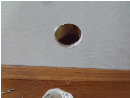
Hulltaking i fra kjøkkendelen
