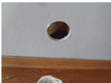
Hulltaking i fra kjøkkendelen
