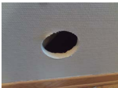
Hulltaking i fra gangen.
