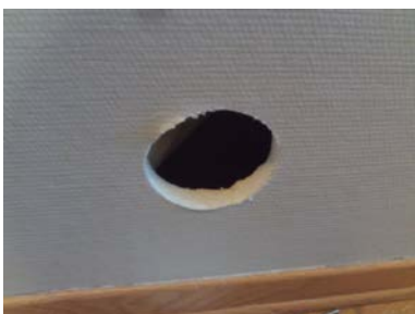
Hulltaking i fra gangen.
