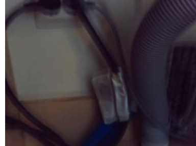
Synlig røropplegg i kjøkkenbenken.
