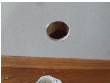
Hulltaking i fra kjøkkendelen
