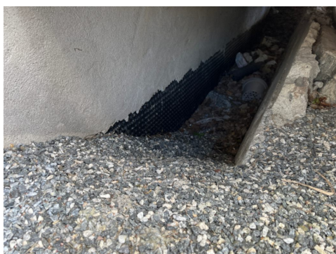
Grunnmurplast avsluttet under terreng.
