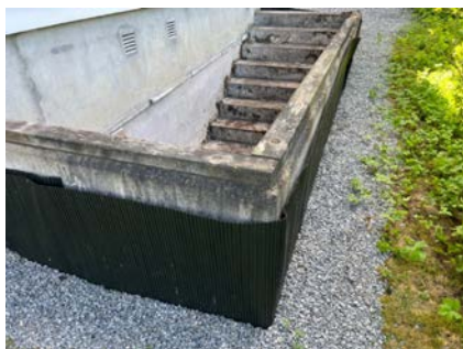
Manglende rekkverk
