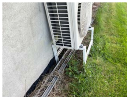
Varmepumpe står skjevt.
