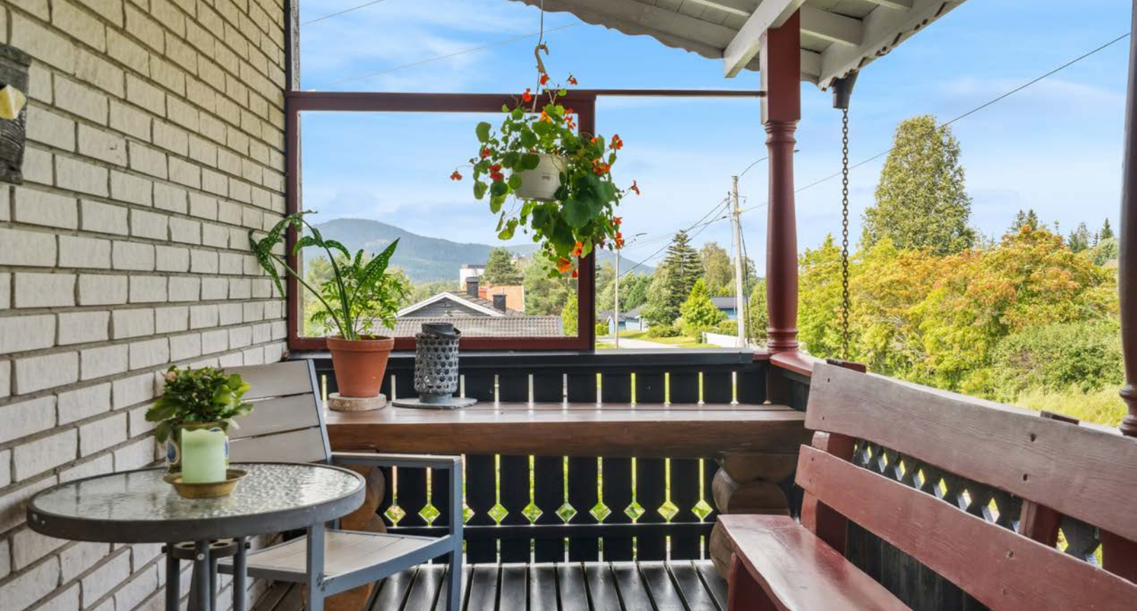
Overbygget inngangsparti med plass til sittegruppe.
