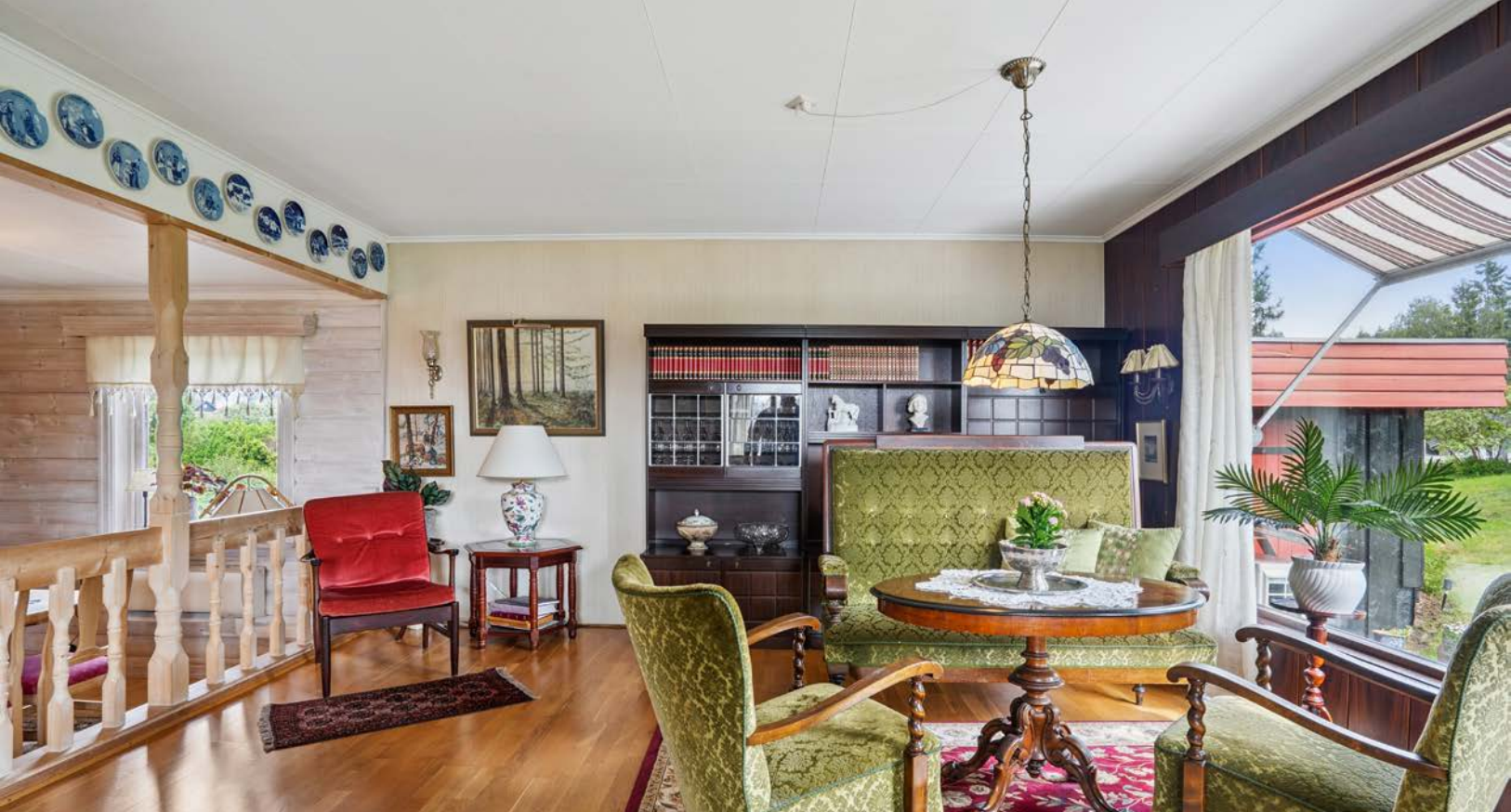
I tillegg varmes stuen opp med varmepumpen som er plassert under vindu i spisestuen.
