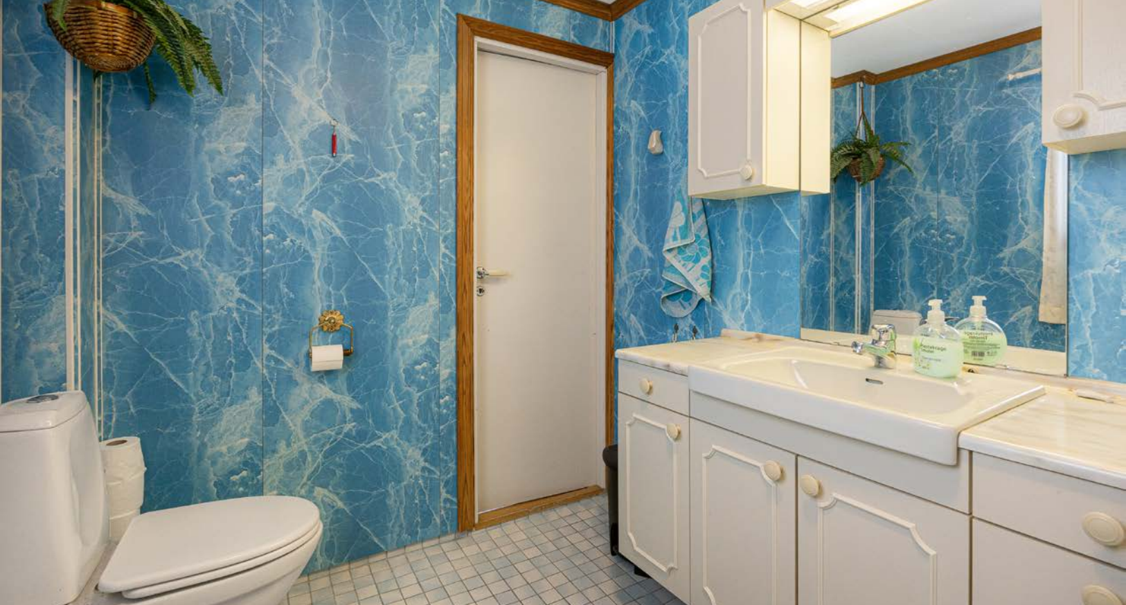
Badet er innredet med våtromsplater på veggene og mosaikkfliser på gulvet. Varmekabler er installert, og badet har toalett og badekar med dusjløsning.
