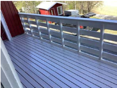
Terrasse over inngangspartiet i 1. etasje.
