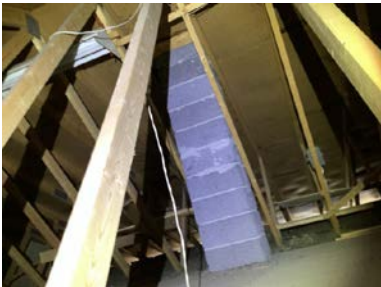
Pipe anbefales pusset på loft.
