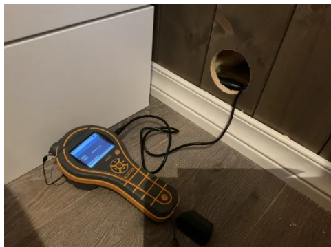
Hulltaking i tilstøtende rom.
