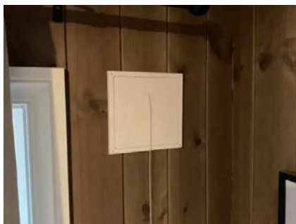
Ventiler i vegger.
