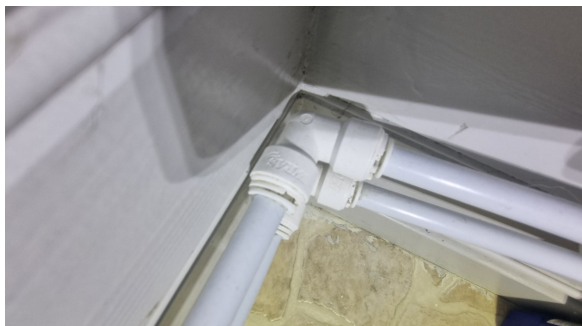
PEX-rør med push-koblinger.
