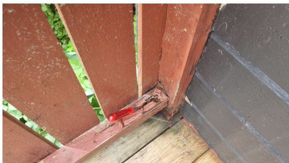
Råteskade i rekkverk.
