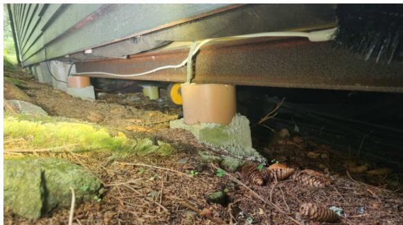
Støpte fundamenter med overliggende H-bjelke.
