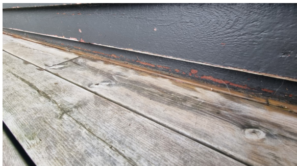
Råteskade i rekkverk.
