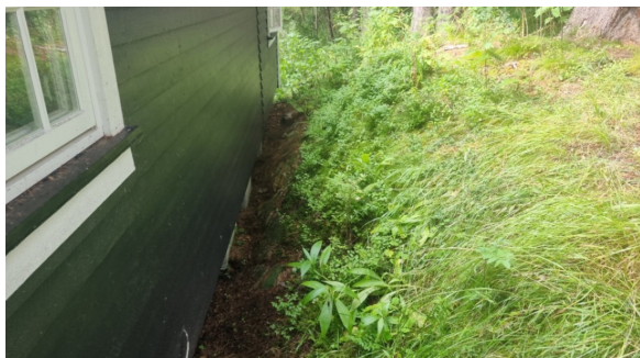
Det er registrert at terrenget har fall mot/under fritidsboligen.
