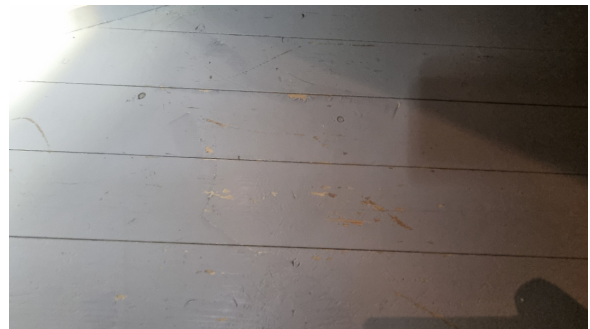
Overflateslitasje.
