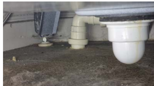
Det er påvist mangelfull/feil utførelse rundt rørgjennomføringer e.l. som gir fare for fukt i konstruksjonen i våtsone.
