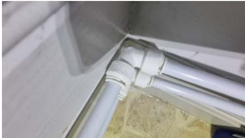
PEX-rør med push-koblinger.
