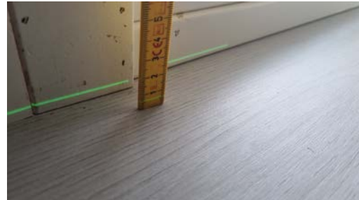
Kontroll av planavvik.
