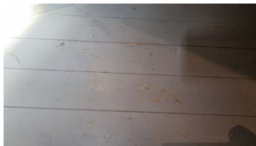
Overflateslitasje.
