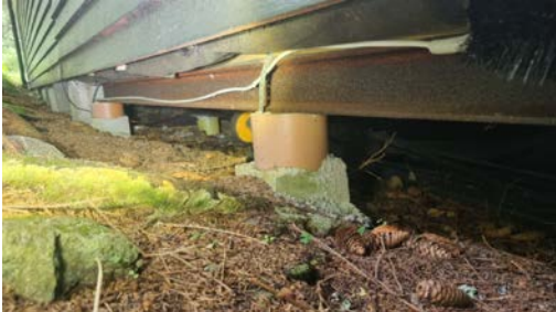
Støpte fundamenter med overliggende H-bjelke.
