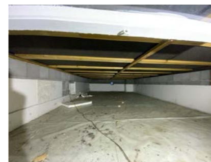
Besiktigelse av kryprom via vindu.
