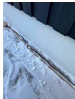
Kontroll av drenering/fuktsikring.
