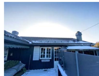
Besiktigelse av taktekke.
