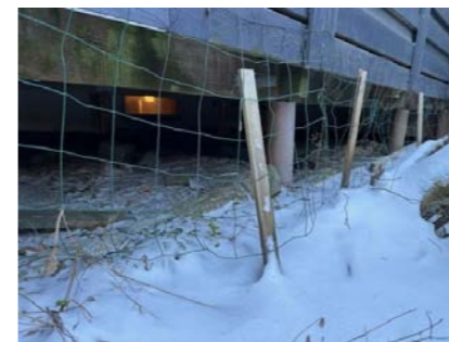
Kontroll av fundament.
