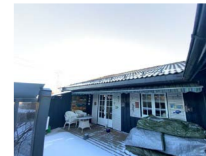
Besiktigelse av taktekke.
