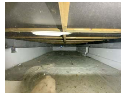
Besiktigelse av kryprom via vindu.
