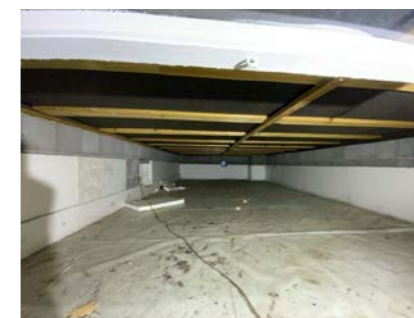
Besiktigelse av kryprom via vindu.
