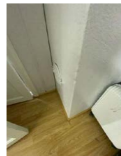
Ildplate under feieluke bør opparbeides.
