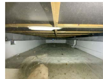
Besiktigelse av kryprom via vindu.
