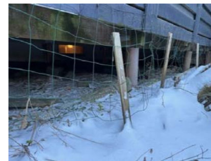
Kontroll av fundament.
