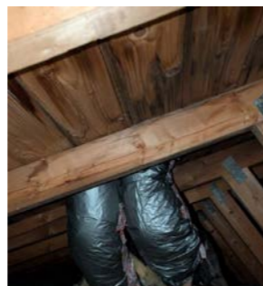
Kontroll rundt rørgjennomføringer.
