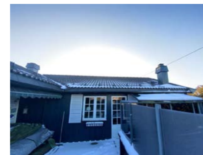
Besiktigelse av taktekke.
