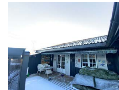
Besiktigelse av taktekke.
