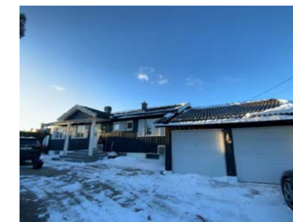
Besiktigelse av taktekke.
