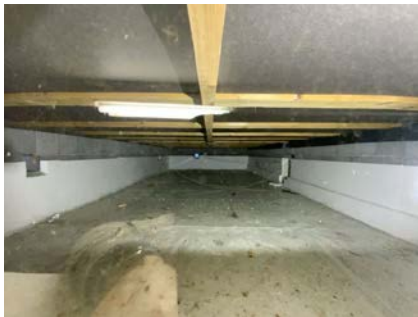
Besiktigelse av kryprom via vindu.
