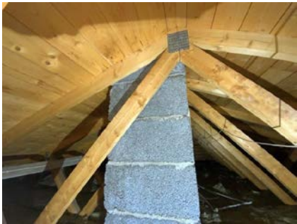
Kontroll rundt pipeløp.
