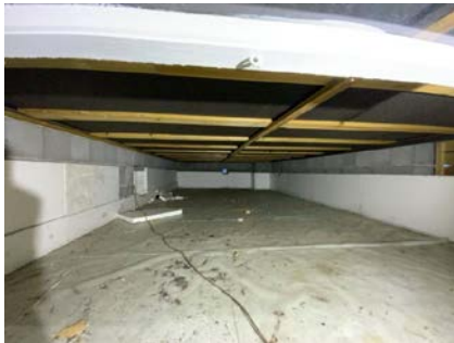
Besiktigelse av kryprom via vindu.
