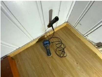
Utført hulltaking på rom under terreng.
