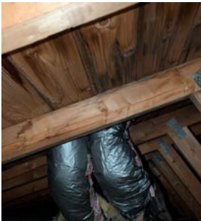
Kontroll rundt rørgjennomføringer.
