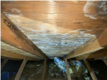
Stedvis soppdannelser på overflater, men eier skal saneringsvaske overflater på salg.
