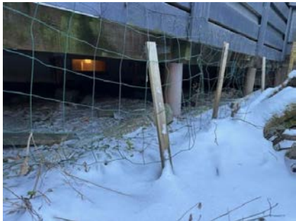
Kontroll av fundament.
