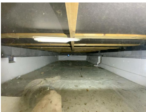
Besiktigelse av kryprom via vindu.
