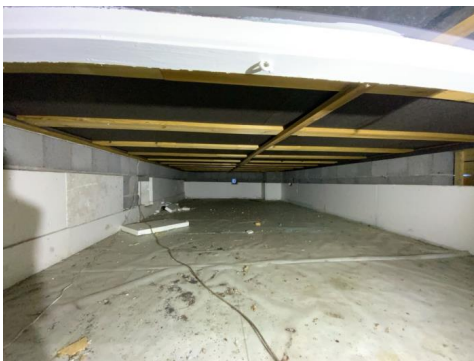
Besiktigelse av kryprom via vindu.
