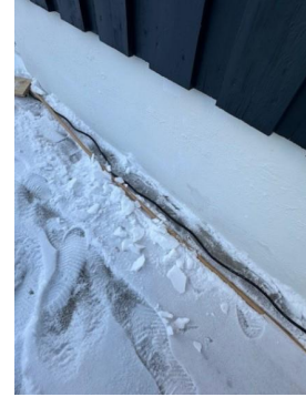
Kontroll av drenering/fuktsikring.
