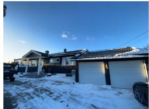
Besiktigelse av taktekke.
