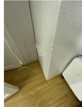
Ildplate under feieluke bør opparbeides.
