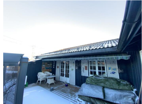
Besiktigelse av taktekke.
