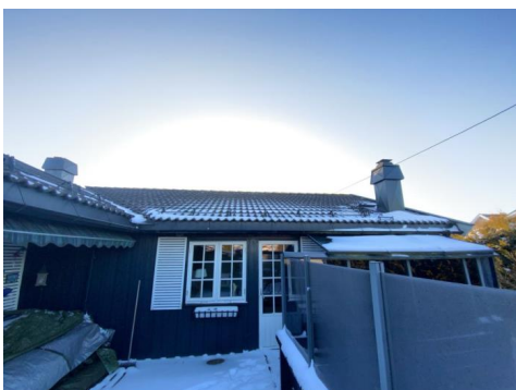
Besiktigelse av taktekke.
