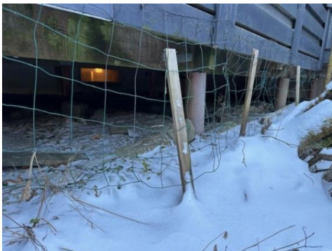
Kontroll av fundament.
