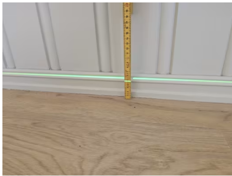
Etasjeskillet ble kontrollert med nivelleringslaser.
