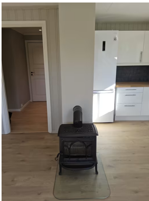
Vedovn tilknyttet elementpipe i stue.
