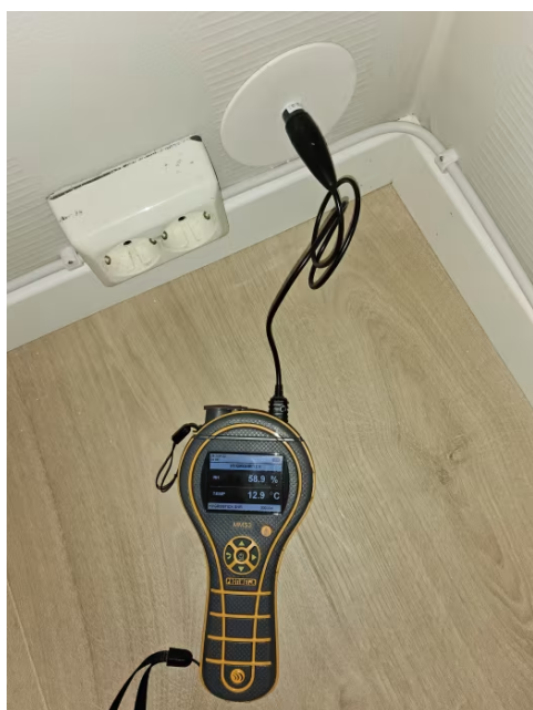
Bilde fra fuktmåling i utlektet vegg.
