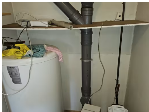
Det registreres riss/sprekk på grunnmur i bod.
