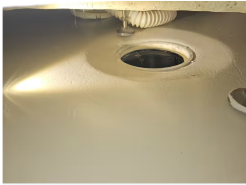
Bilde viser sluk med klemring uten skruer.
