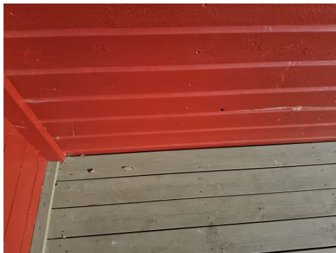
Trekledning er avsluttet under terrassegulv.
