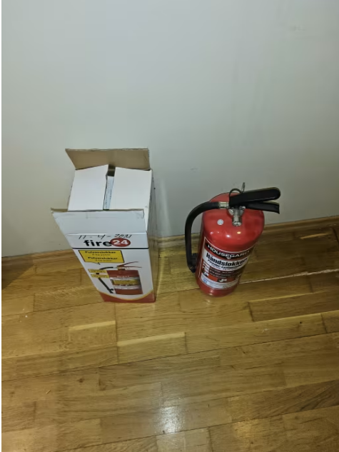
Brannslukningsapparat er plassert på bod.
