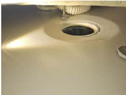
Bilde viser sluk med klemring uten skruer.
