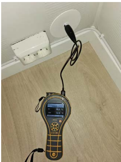
Bilde fra fuktmåling i utlektet vegg.
