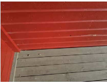
Trekledning er avsluttet under terrasegulv.
