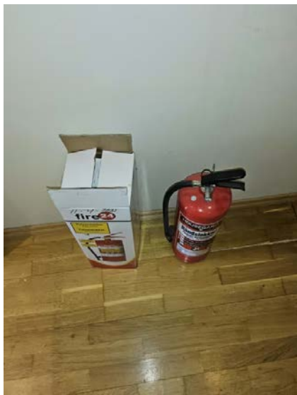
Brannslukningsapparat er plassert på bod.
