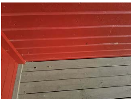
Trekledning er avsluttet under terrassegulv.
