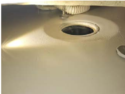
Bilde viser sluk med klemring uten skruer.
