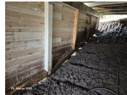
Bærekonstruksjon er utsatt for høy fuktpåkjenning på grunn av forholdene som vises på bildet.
