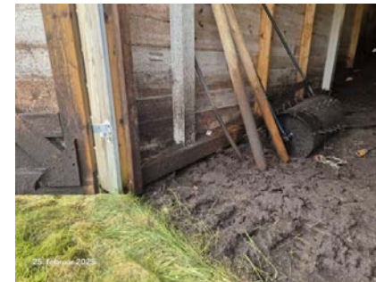
Bærekonstruksjon er utsatt for høy fuktpåkjenning på grunn av forholdene som vises på bildet.
