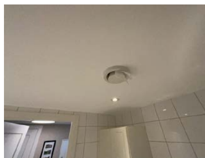
Mekanisk avtrekk.
