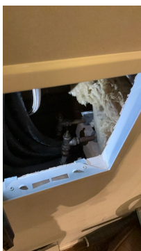
Samlestokkskap til vannledninger til bad
