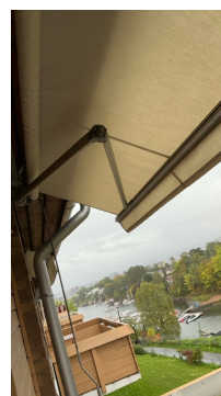
Det er etablert manuell markise på balkong
