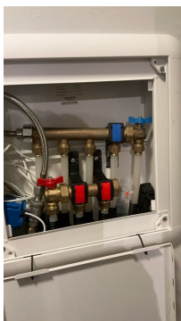
Samlestokkskap til vannledninger til bad
