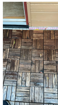
Synlige fliser på betongdekke, samt overliggende tremmegulv i tre.
