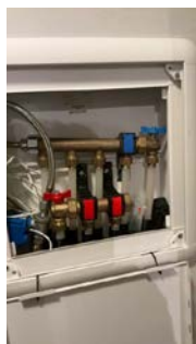
Samlestokkskap til vannledninger til bad
