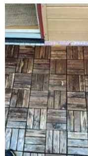
Synlige fliser på betongdekke, samt overliggende tremmegulv i tre.
