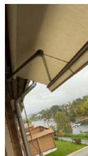
Det er etablert manuell markise på balkong
