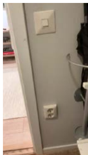
Original ryter og stikkontakt i bod.
