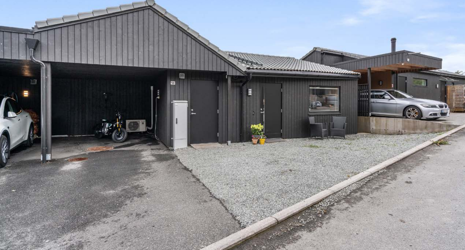
Inngangsparti, sportsbod og carport med elbillader
