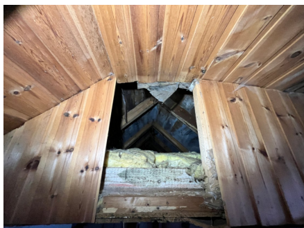
Fuktskader i bordtro
