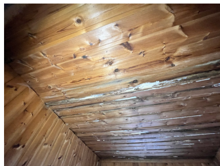
Fuktskader og råte i himling på loft
