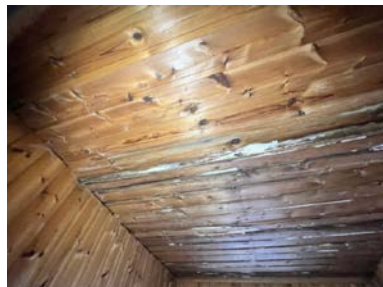
Fuktskader og råte i himling på loft
