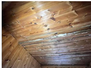
Fuktskader og råte i himling på loft
