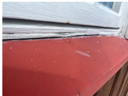
Vindu på sørøst side 2 etasje, råteskade
