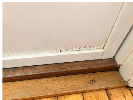
Fuktskade på dør, balkong 2 etasje
