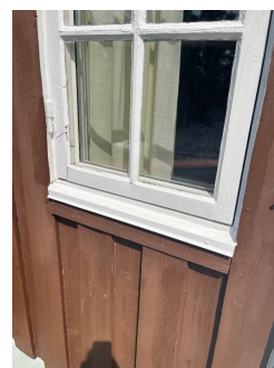
Vindu på sørøst side 2 etasje, råteskade
