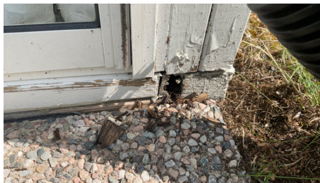
Nedre hjørne ved takrennenedløp.
