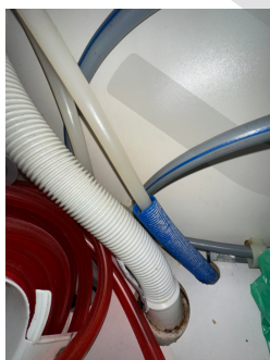
Manglende tettemuffer på vannrør
