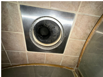
Sluk i plast, plassert i dusjnisje
