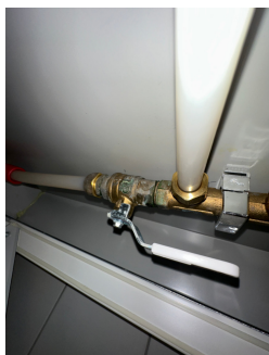
Manglende tettemuffer på vannrør
