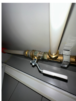
Manglende tettemuffer på vannrør
