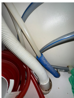
Manglende tettemuffer på vannrør
